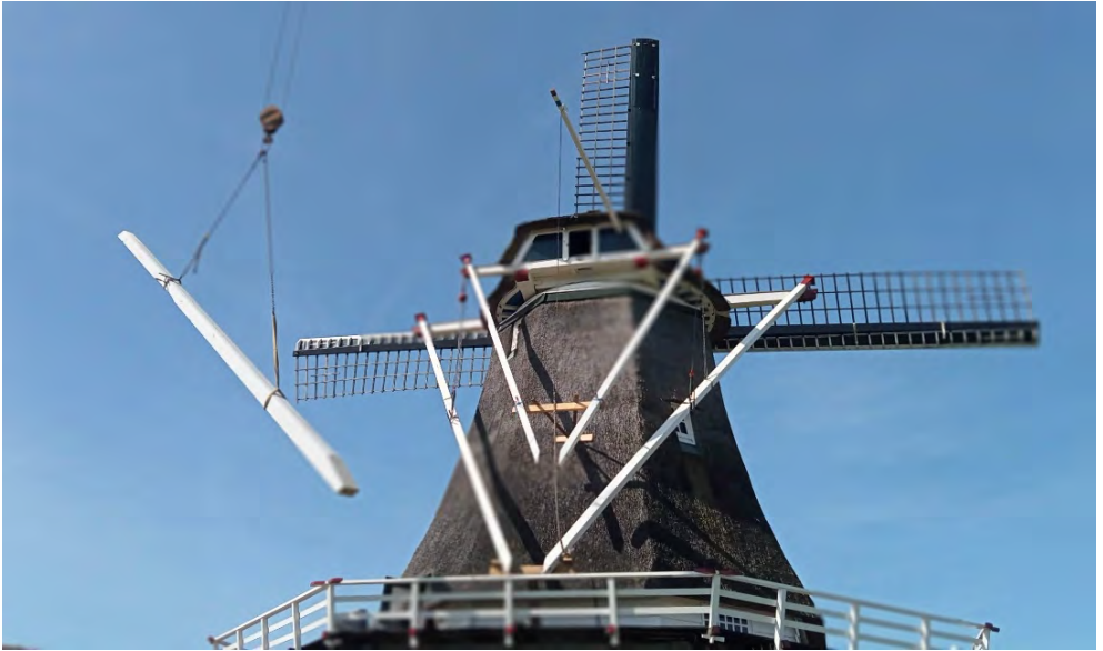
Het aanbrengen/plaatsen van de nieuwe staartbalk Het sfeervolle "Walking Diner"
